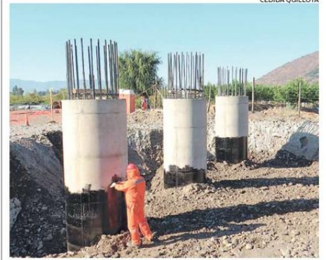
OBRAS TIENEN 12% DE AVANCE Y TERMINARÁN EN ENERO DE 2019.
