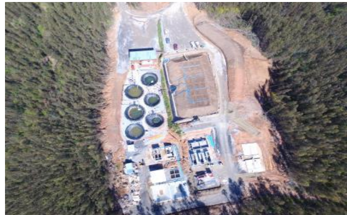
Vista aérea de planta piloto proyecto Biolantánidos
